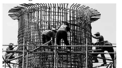
Pekerja menyelesaikan pembangunan Jalan Tol Cengkrang-Batu Ceper-Cikunir di Jalan Daan Mogot, Batu Ceper, Kota Tangerang, Banten, Minggu (12/4/2020). Tol sepanjang 14,19 kilometer ini menelan biaya investasi sekitar Rp 3,5 triliun. Ruas tol ini akan menambah variasi rute yang dapat digunakan menuju dan dari Bandara Soekarno-Hatta ke Tangerang. Proyek infrastruktur ini masih berjalan di tengah pandemi Covid-19.
