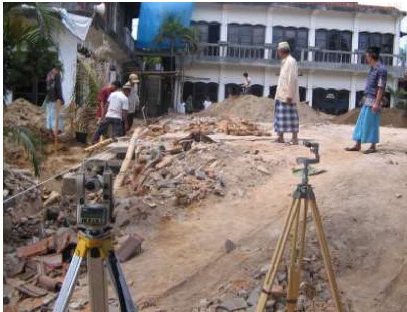
Pengukuran arah kiblat menggunakan Theodolit
